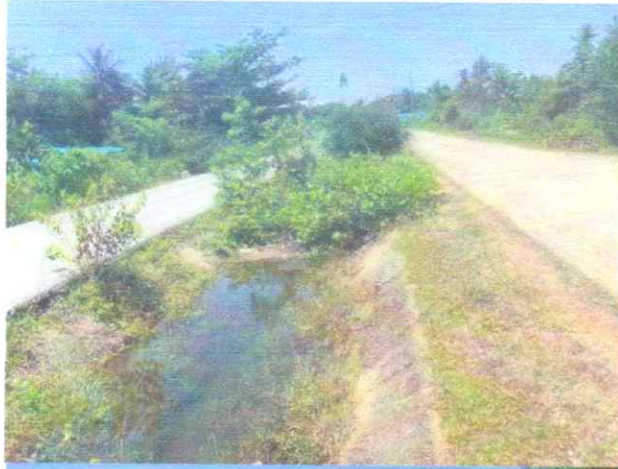
คลองส่งน้ำชลประทาน (สาย ๑๒ ซ้าย ๑ ซ้าย ๑๔ ขวา)
